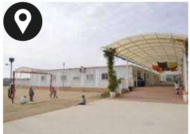
Escuela El Calderí de Caldes de Montbui 2015
